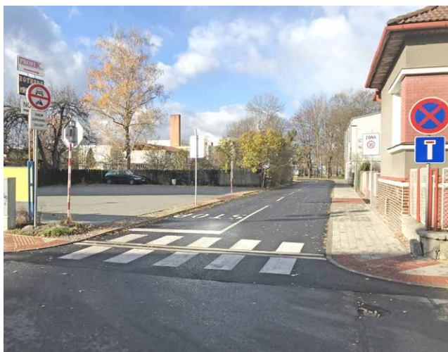
Rekonštrukcia časti Pišútovej ulice - druhá časť.
